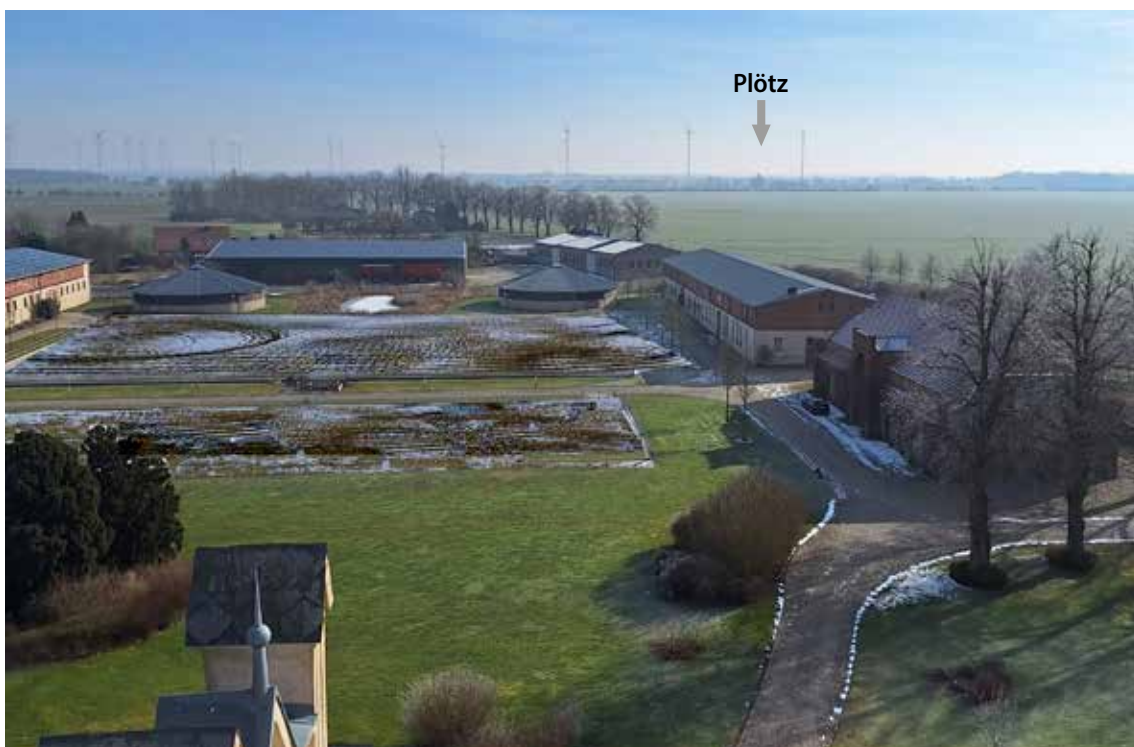
Der gestörte Blick vom Turm des Schlosses Kartlow nach Südosten zum Herrenhaus Plötz.
