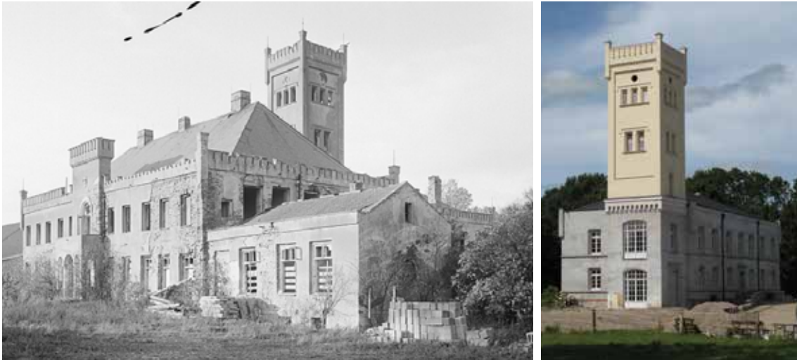
Links: Herrenhaus Plötz. Im Vordergrund der 1851 ummantelte Barockbau, dahinter der 1869 errichtete Turm, 1989; rechts: Das verbliebene neue Herrenhaus und der Turm nach dem Abriss des Barockbaus, 2010. Fotos: Deutsche Fotothek / Messbildstelle Dresden und Thomas Helms, Schwerin
